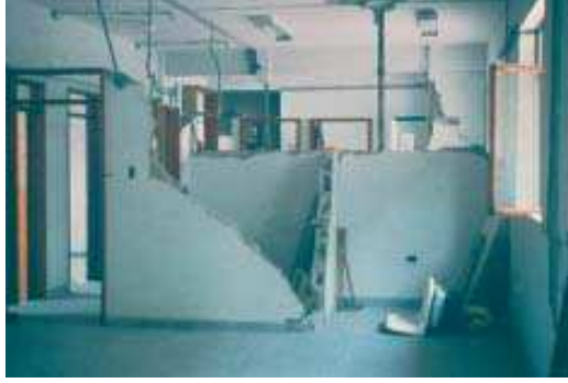
شكل (35): أضرار وتشققات قطرية في الجدران الداخلية المحمولة (1)
