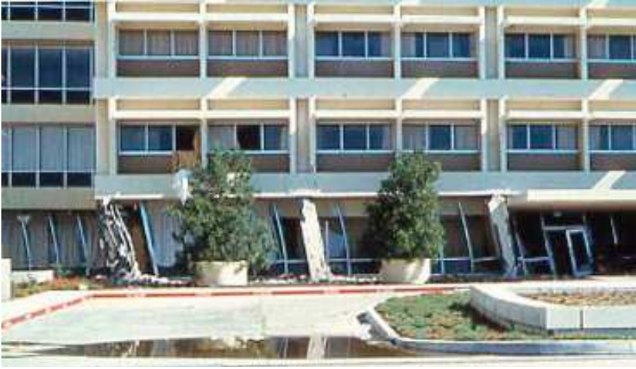
شكل (63): صورة لمستشفى أوليف توضح التشوه الشديد للأعمدة فوق مستوى الساحة 1
