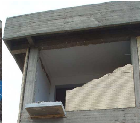
الشكل (38): تساقط قطع الجدران الخارجية بسبب تأثير الحركات الاهتزازية (تقارير المعهد EERI) 1
