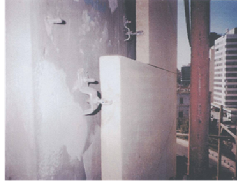
أ- تربيط ميكانيكي لقطع الحجر بدون استخدام الخرسانة
