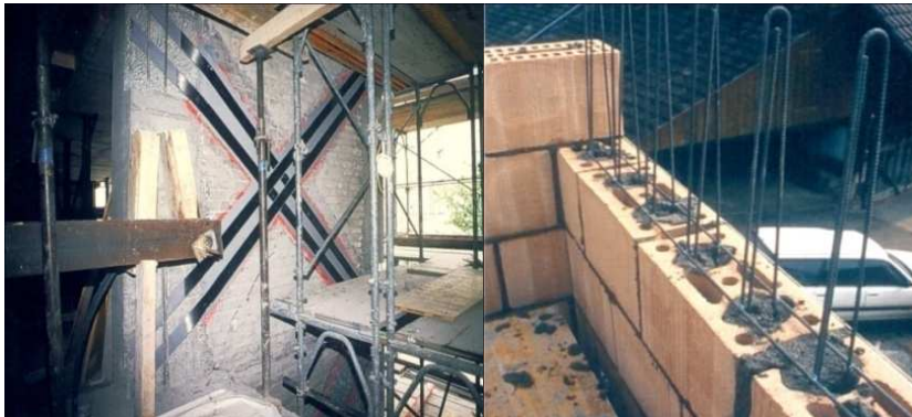
الشكل (36): تثبيت أو تسليح الجدران الخارجية الغير حاملة (المحمولة) 1
