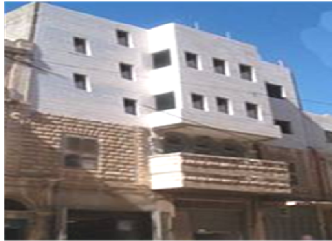
ب- جدران حاملة غير مسلحة (الطابق الأرضي الأول) تحمل طابقين نظامهما الإنشائي يتكون من أعمدة وجسور خرسانية مسلحة
