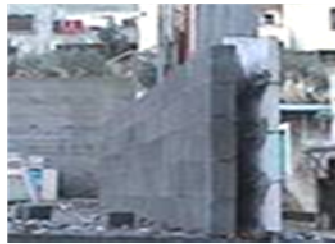
ب- بعد بناء القطع الحجرية والطوب يتم صب الخرسانة بينهما
