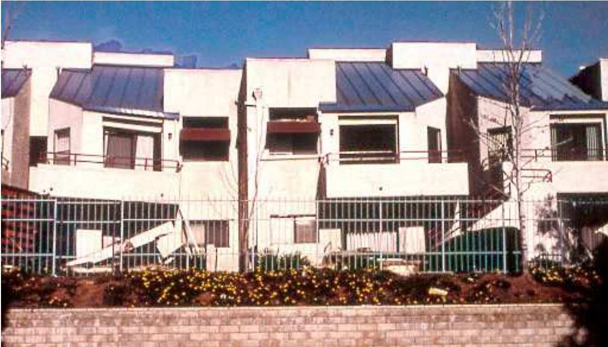
شكل (68): نوضح انهيار الطابق الأرضي للمنزل السكني بعد زلزال نورثريدج 1994 (1)
