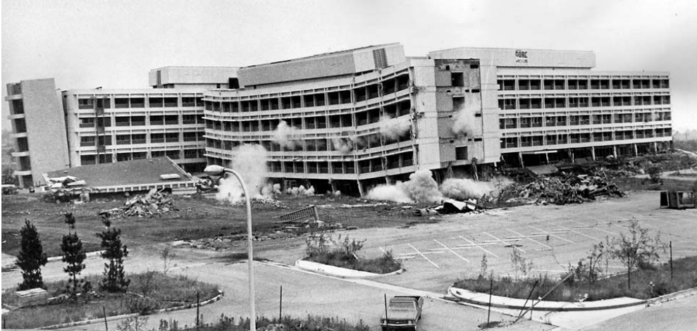
شكل (65): صورة توضح الارتطام الحاصل بالمستشفى أثناء وقوع زلزال سان فرناندو 1971 بكاليفورنيا (المصدر: وكينديا الموسوعه الحره)
