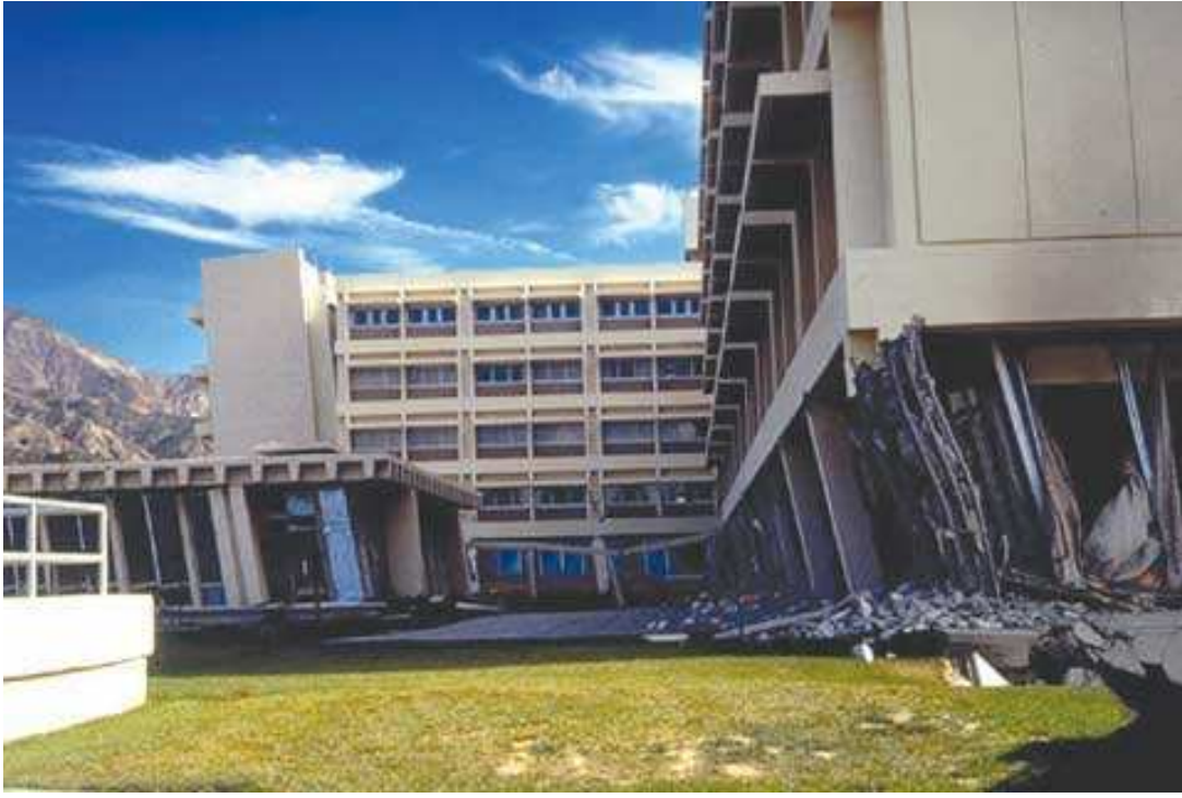
شكل (66): صورة لمستشفى أوليف توضح التشوه الشديد للأعمدة فوق مستوى الساحة 1
