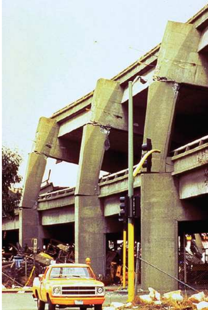
شكل (88): زلزال سان فرانسيسكو 1989 الجسر العلوي للطريق السريع، حدوث قص للأعمدة 2
