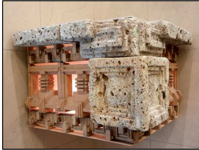
شكل (60): طريقة تركيب الحجر (الإكساء الخارجي) المصدر: ويكيبيديا الموسوعة الحرة
