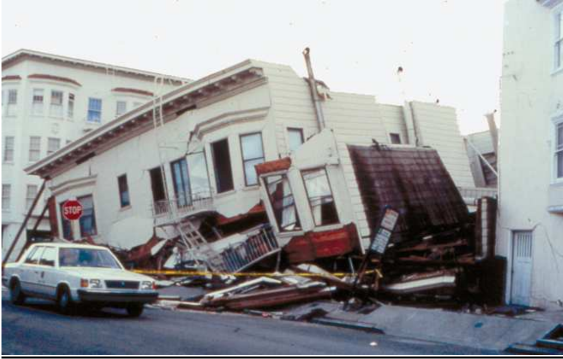
شكل (89): منزل سكني منهار في منطقة الماريننا بسان فرانسيسكو الناجمة عن هزة أرضية قوية (قوى قص) ووجود الطابق الرخو. المصدر: (NIST) National Institute of Standards and Technology
