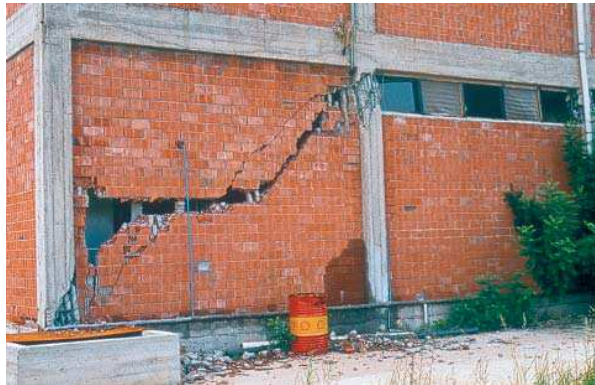
شكل (34): إن الجدار البنائي هو الأقوى، ففص الأعمدة الكبيرة نسبياً (زلزال أضنة - جيهان، بتركيا 1998) 2
