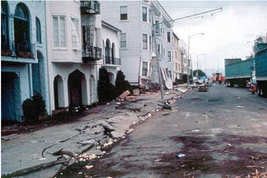
شكل (90): تصدع المباني بسان فرانسيسكو 1989 الناجمة عن ضعف التربة 1
